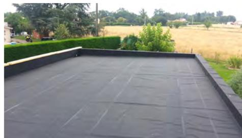
Dérouler, déplier, caler. Les trois étapes pour installer la membrane **Lizy®Roof 3D by SOPREMA** et assurer une étanchéité durable.
